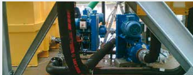
Unterlauf Siebmaschine, Zyklone und Pumpen im Einsatz zur Sandklassierung , je ca. 100 m 3 /h Pumpe 1: für Sand 0,5 – 2 mm, 50 t/h, Trennschnitt bei ca. 0,063 mm Pumpe 2: für Sand 0 – 0,5 mm, 30 – 40 t/h, Trennschnitt bei ca. 0,063 mm
